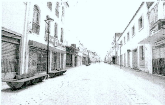
Bancos de madeira foram instalados ao longo de parte da via que já está com obras concluídas
