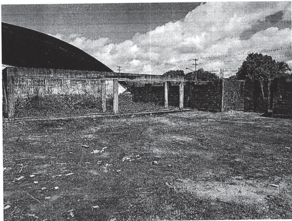
Vista panorâmica do pátio evidenciando o pórtico da passarela concluído.
