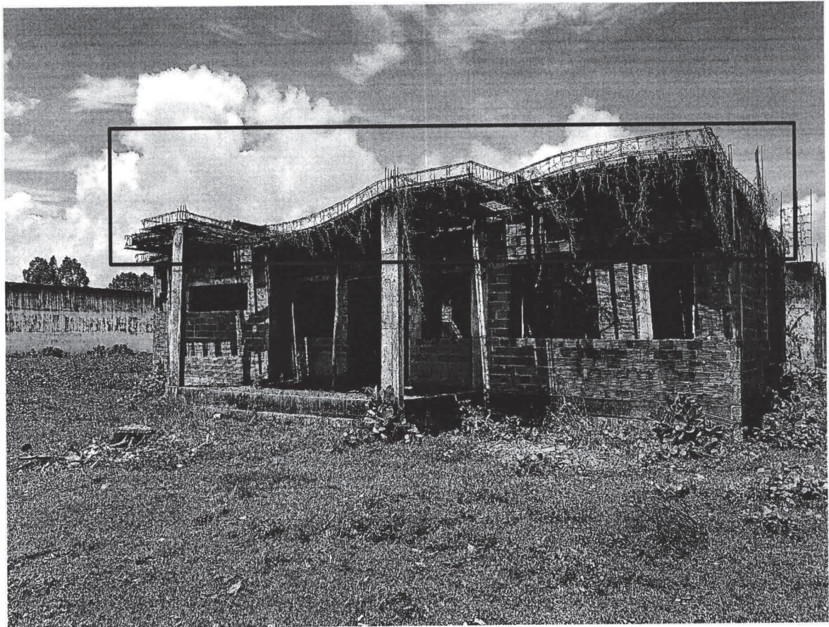
Imagem da edificação evidenciando os elementos pré-moldados da laje e as armaduras da viga posicionadas
