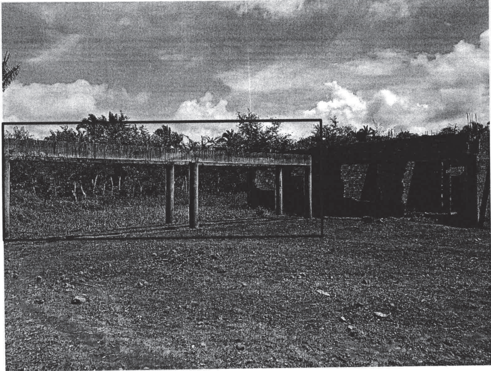
Imagem evidenciando pórtico com todos os elementos executados.
