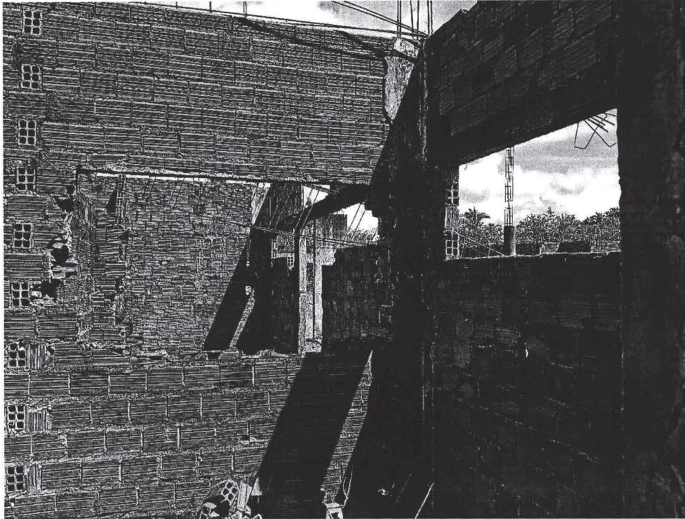
Imagem do interior da sala evidenciando paredes parcialmente demolidas.
